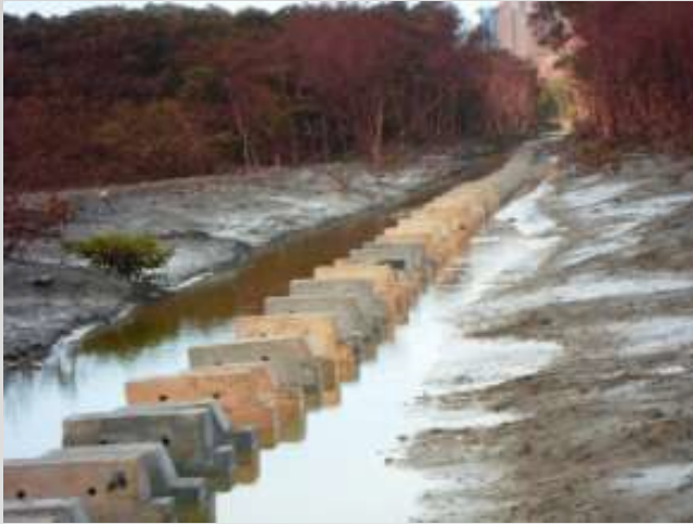
Montagem e Instalação do Emissário Subaquático Porto Itaqui -MPX – São Luis /MA
