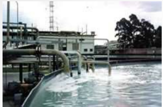
Montagem da linha de Tubul. (PP) Descarte de Efluentes – Viscofan /SP
