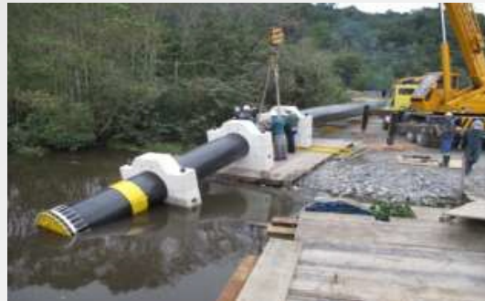
Montagem dos blocos de ancoragem \varnothing 900mm – Consbem Porto de Santos/SP
