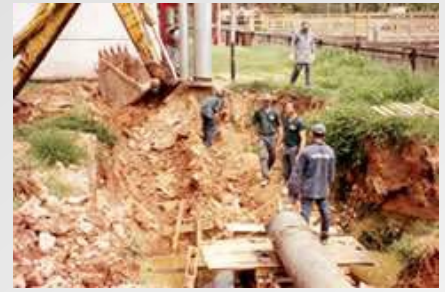
Montagem da linha PEAD Brahma – Jacareí
