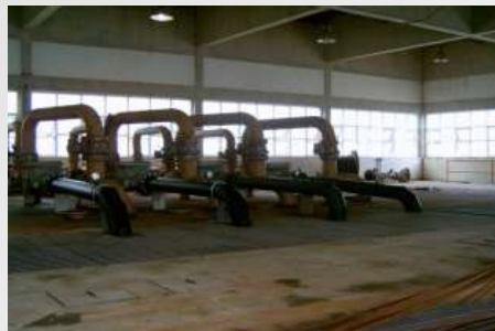
Linha de PEAD e Aço Sabesp – Suzano/SP
