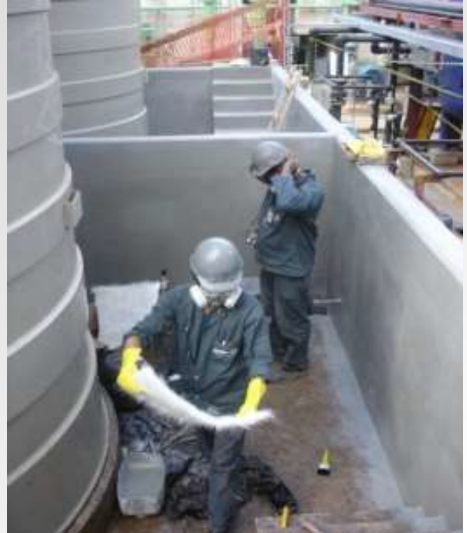
Fabricação de Tanques em PP e revestimento de diques de contenção
