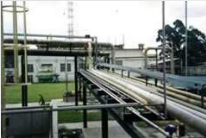
Montagem da linha de Tubul. (PP) Descarte de Efluentes – Viscofan /SP
