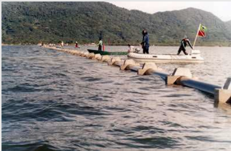
Montagem e Instalação de Emissário Subaquático – CASAN – Santa Catarina
