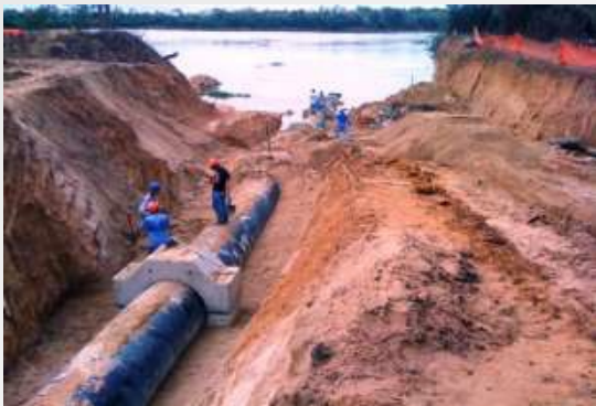
Emissário terrestre c/ Tubos PEAD \varnothing 1.200 – CMT Roraima/RO
