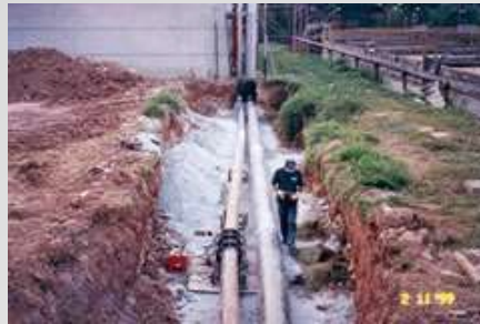
Montagem da linha PEAD Brahma – Jacareí
