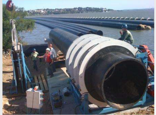
Montagem do Emissário Marítimo PEAD – DMAE Porto Alegre /RS
