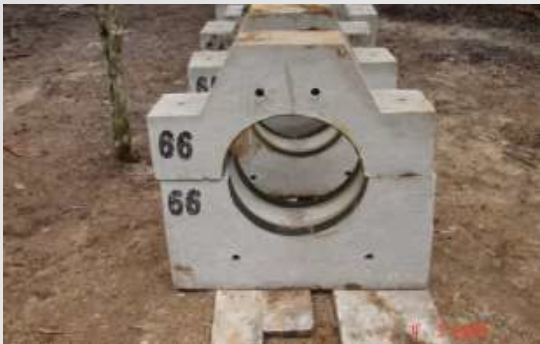
Montagem dos blocos de ancoragem \varnothing 900mm – Consbem Porto de Santos/SP
