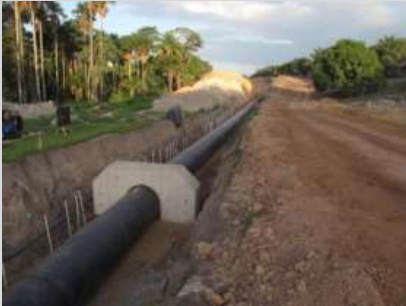
Montagem Emissário terrestre PEAD Ø 1.200mm CMT - Marabá /RO
